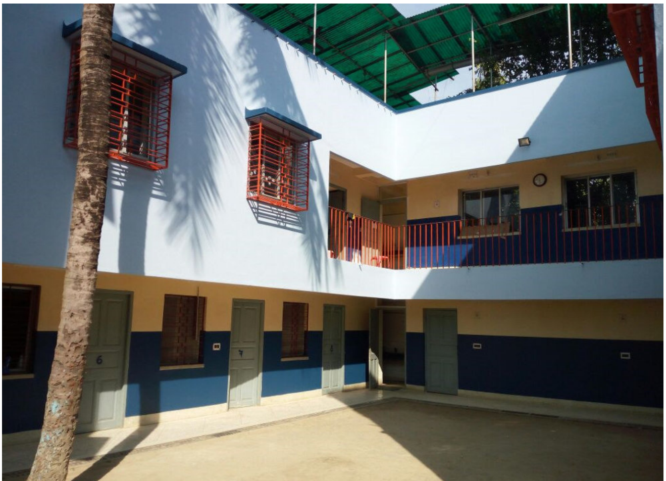
oben: altes Mauerwerk mit Rissen, unten: Innenhof neu verputzt und gestrichen
