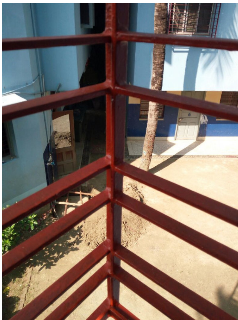
oben: rostige Fenstergitter, unten: Fenstergitter entrostet und lackiert
