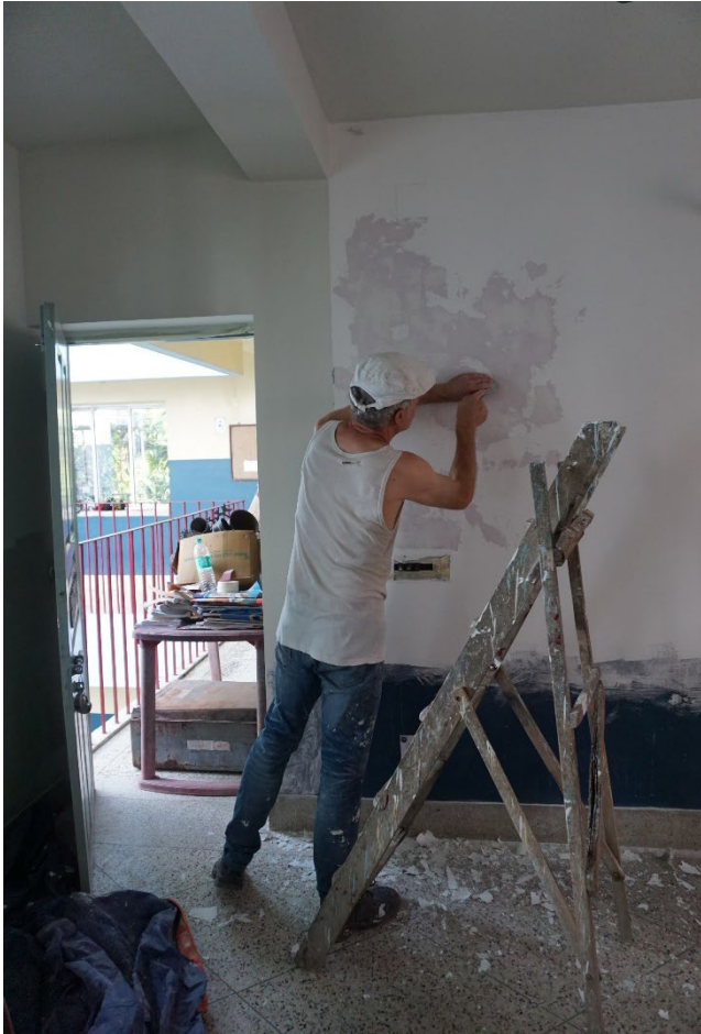
Bevor gestrichen wird muss alles verspachtelt werden.
