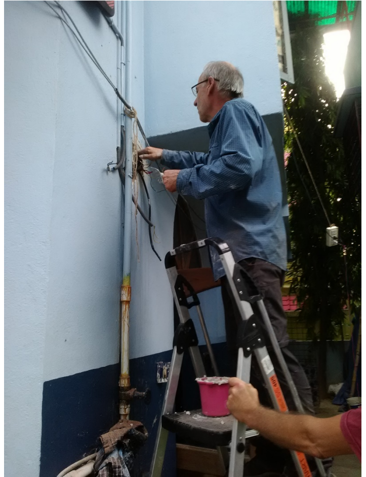
Nach dem Gipsen werden die Drähte gezogen.
